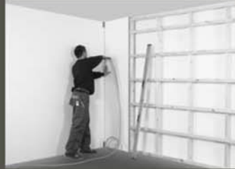
2 Bevestigen in hoek dwars door het paneel (op 10 mm van de paneelrand).
