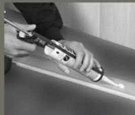
Montage plint. Lijm aanbrengen op de achterkant.
