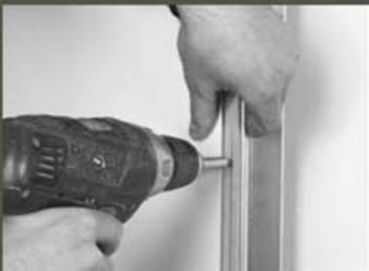
Schroeven*. Noot: voorkeur schroeven 3,5 mm.
