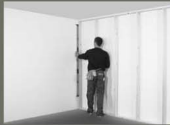
De constructie moet stevig, waterpas (zowel horizontaal als verticaal) en haaks zijn!
