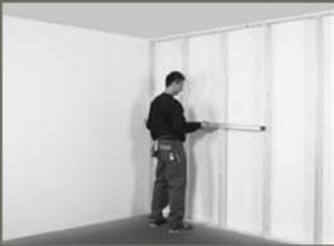
De constructie moet stevig, waterpas (zowel horizontaal als verticaal) en haaks zijn!
