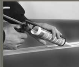
Bevestiging hoekprofiel. Lijm aanbrengen op de achterkant.
