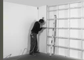
3 Bevestigen op de uitsparingen van het Uniclic®-profiel (om de 400mm).
